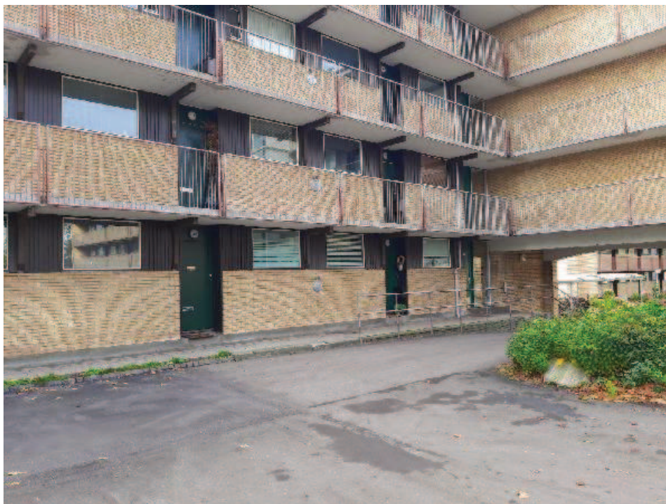
Ryttergårdsvej 18 og 20, kælder, 3520 Farum
