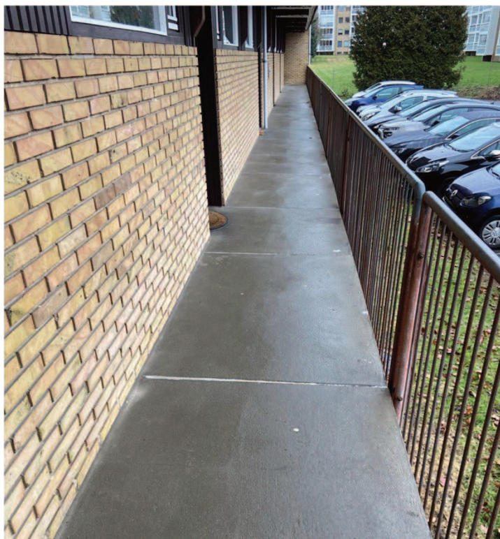
Overside skal males for at forhindre gennemsvivning Males med skridsikker maling
