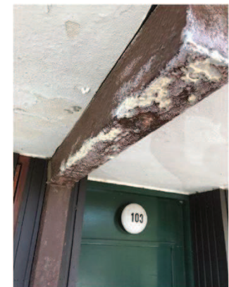
Afskallet brandmaling
