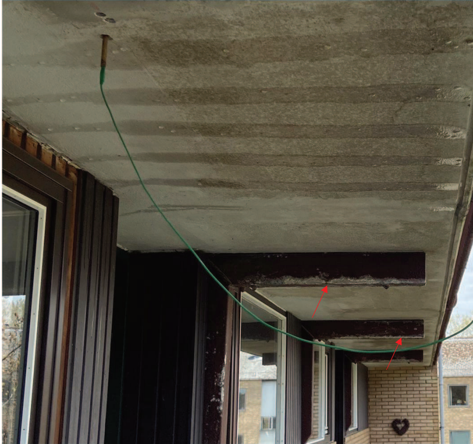
Afskallet brandmaling på stålforstærkninger -> SKAL reetableres grundet brandsikkerhed..
