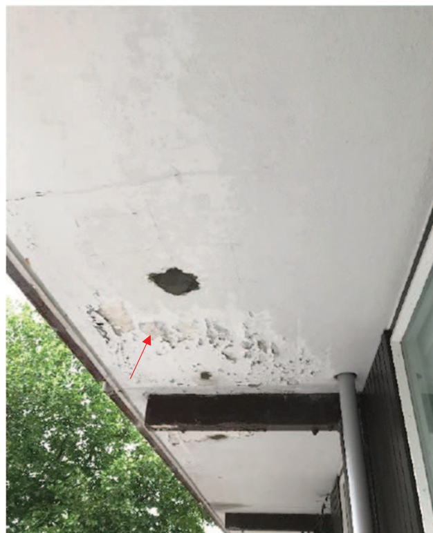
Gennemsvivning = afskalning af maling
